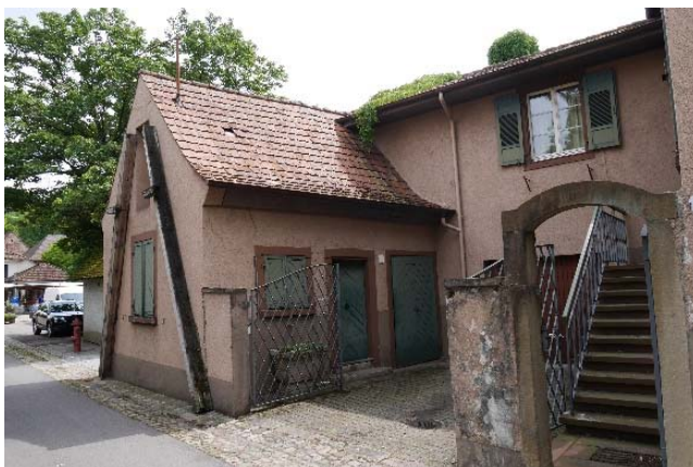
Häuser Frickstraße 2 und 3 sowie Eingang zu Haus Frickstraße 2 mit dem Zwischenbau und der ehemaligen Brennerei, 2020.
