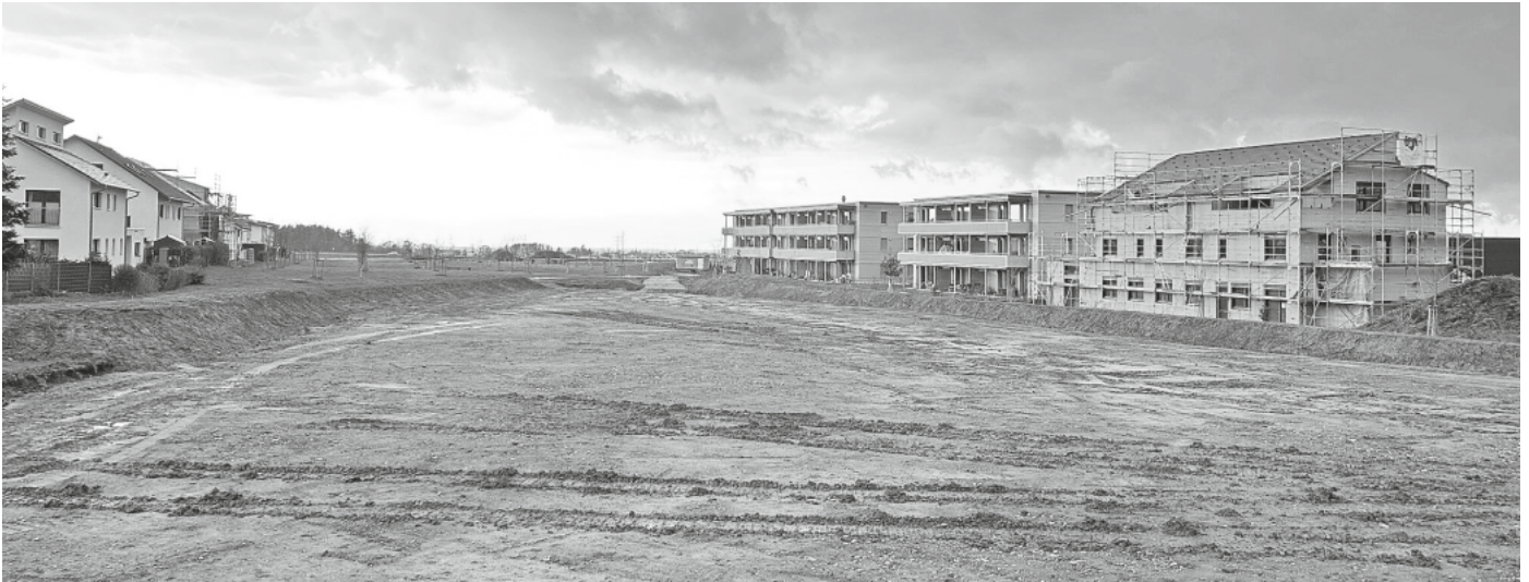
Vorbereitete Fläche mit abgeschobenem und seitlich gelagertem Oberboden Foto: Jens Schlenig
