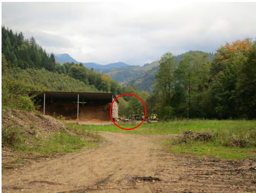
Foto 7: Hackschnitzelplatz mit Lagerhalle, geplanter Standort für Geschirrhütte
