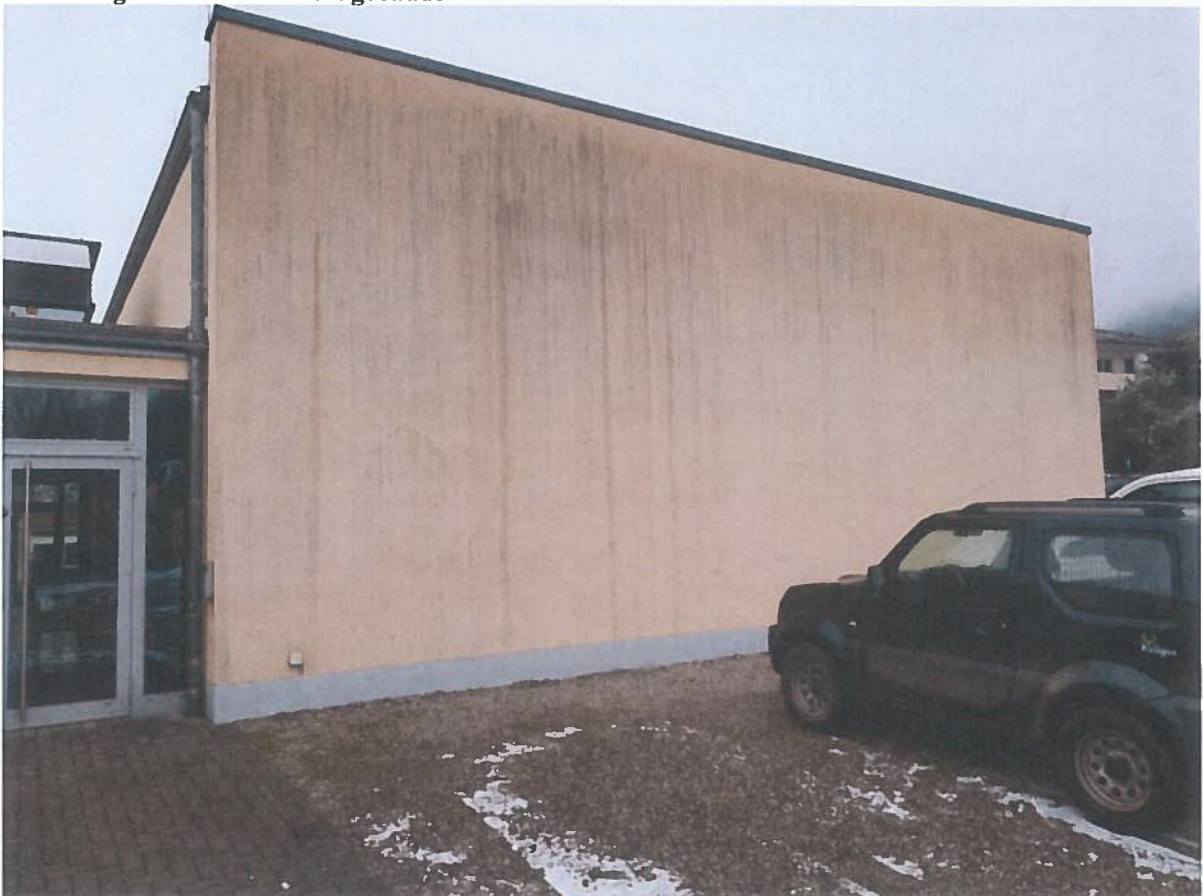
Abbildung 8: Südwand Südgebäude mit weiteren Sommerhabitaten der Fledermäuse
