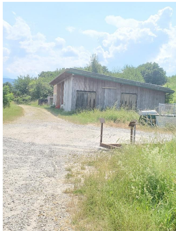
Foto 4: Maschinen / Gerätehalle im Norden
