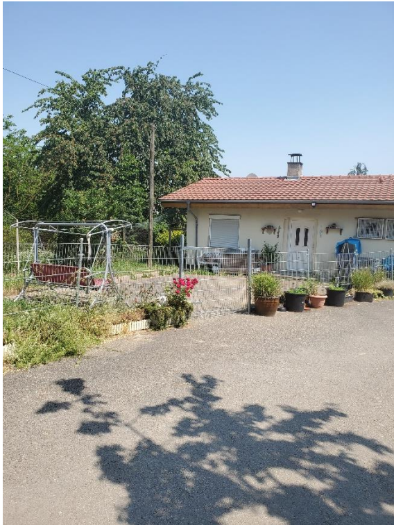
Foto 1: Bestehendes Wohngebäude im Eingangsbereich
