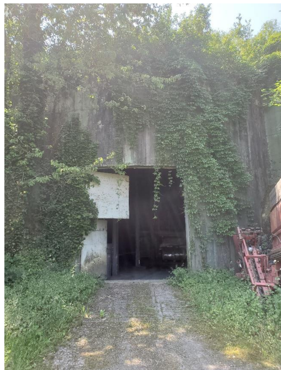
Foto 8: Blick auf den Eingang einer der beiden Tanks
