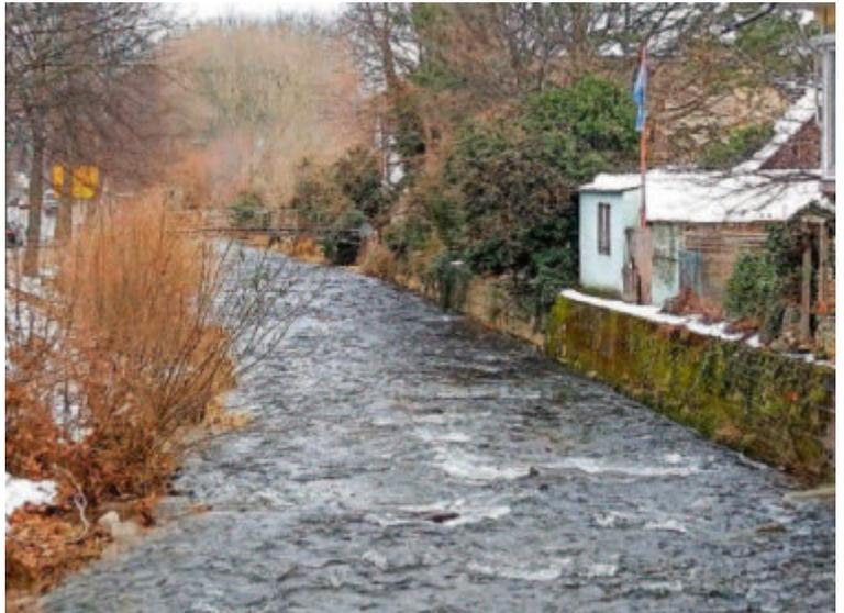
Das RP hat bereits untersucht, ob die historische Mauer erhöht werden kann. Die geotechnischen und statischen Untersuchungen der Mauer und des Baugrunds hatten allerdings ergeben, dass eine solche Erhöhung für die erforderlichen Hochwasserschutzmaßnahmen nicht geeignet ist. Daher ist der Neubau einer ausreichend hohen Mauer vorgesehen.
