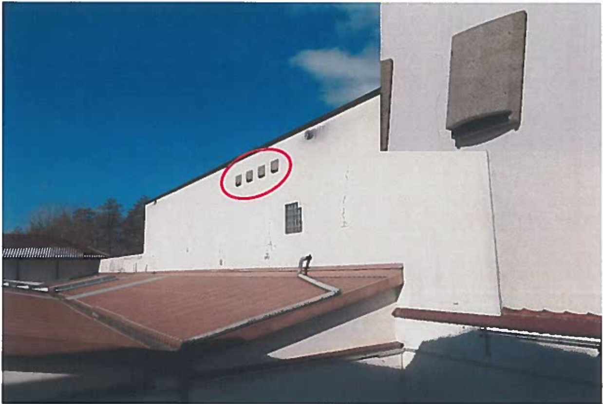
Abb. 2: Hangplatz der 4 Fassadenkästen von der Firma Naturschutzbedarf Strobel
