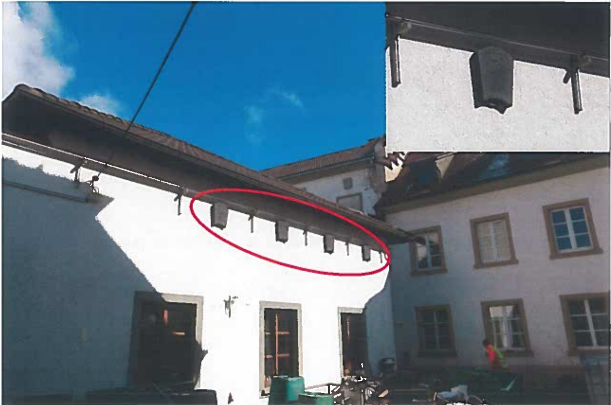
Hangplatz der 4 Fassadenkästen von der Firma Vivara
