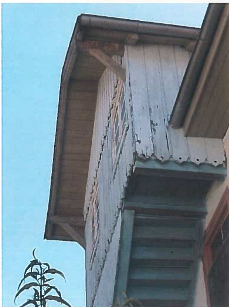
Abb. 6: Holz-Treppenanbau im Bereich des Altbaus. Hier Verdacht auf ein Zwergfledermaus-Wochenstubenquartier im linken Dachbereich und ein Zwergfledermaus-Einzelquartier an der Ecke rechts unten.
